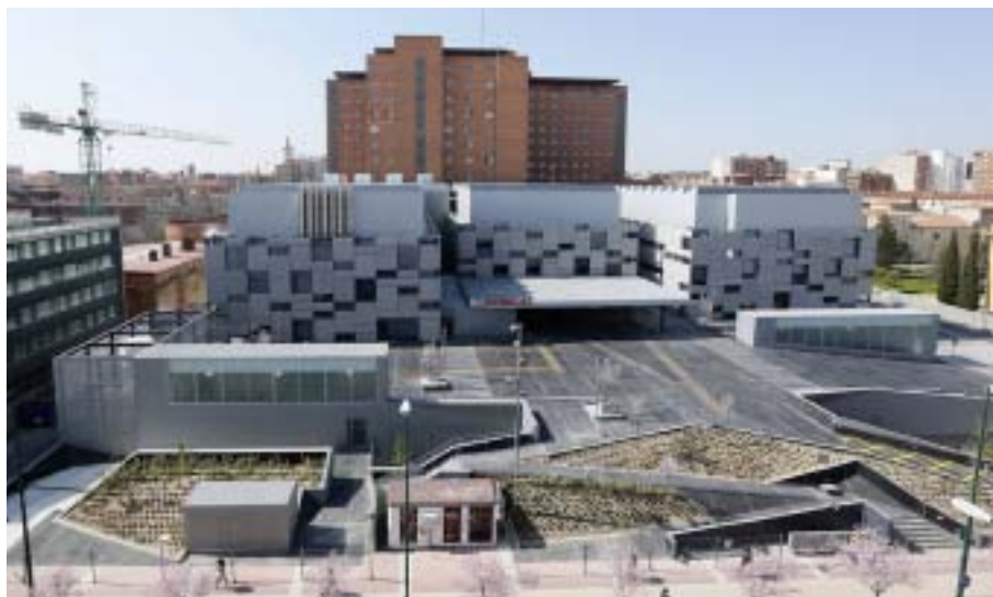
Ampliación del Hospital Clínico.
